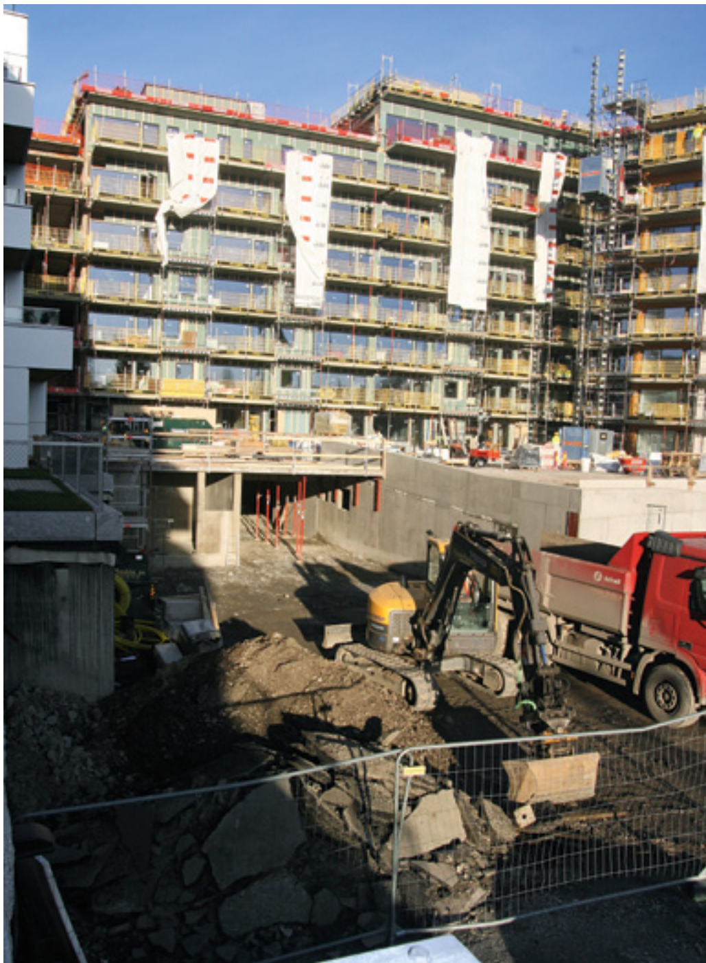
Ikke tilgjengelig oppstillingsplass. Skal ryddes raskt.
