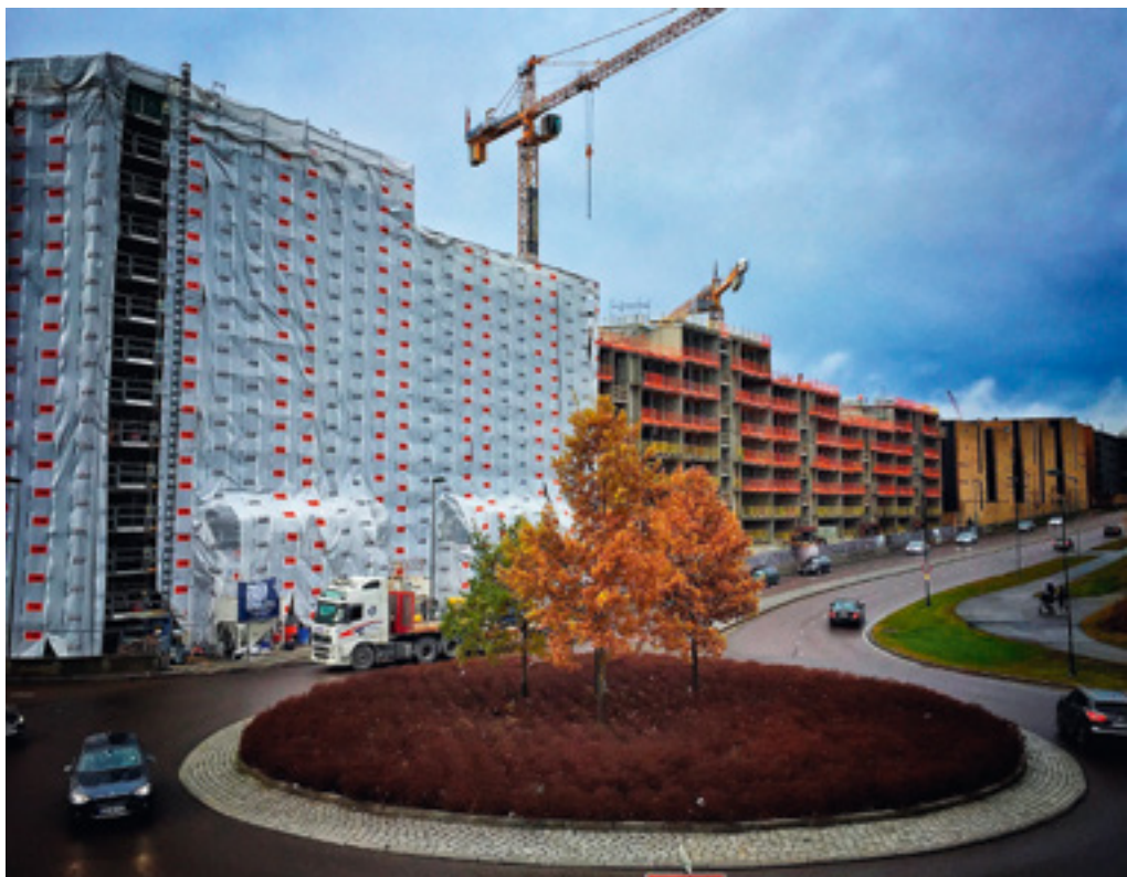
Det er stor byggeaktivitet i Lørenskog, og dette fører til problemer for brannvesenets innsatsmuligheter.
