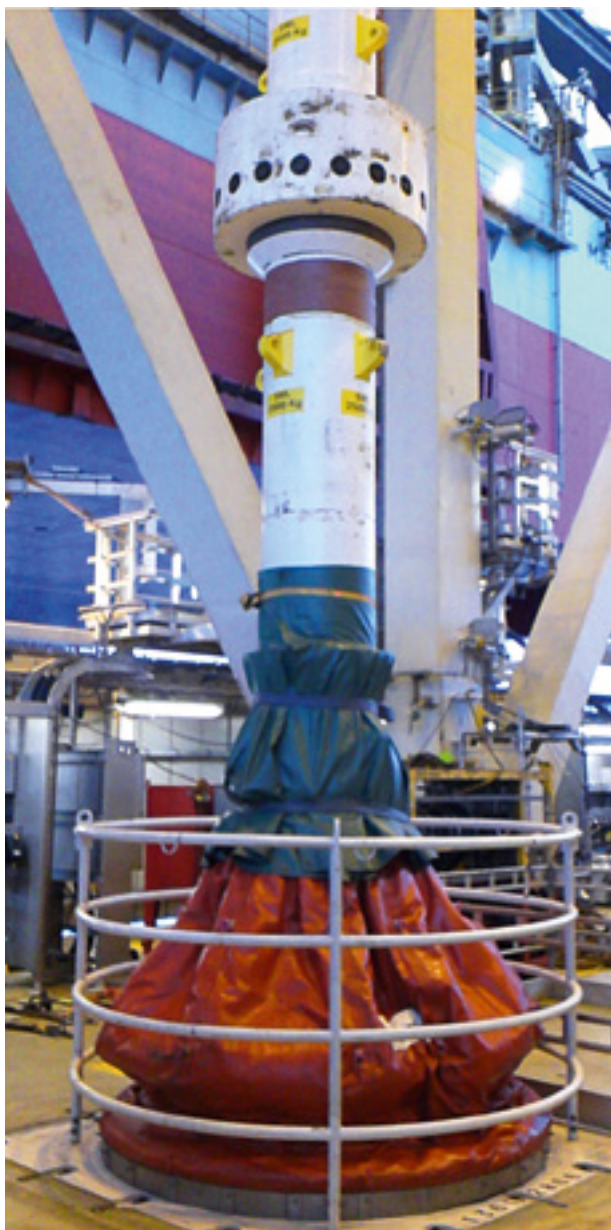
Fleksibel løsning. Belgen er testet og godkjent for jetfire 350 kW/m 2 (1300 °C).
